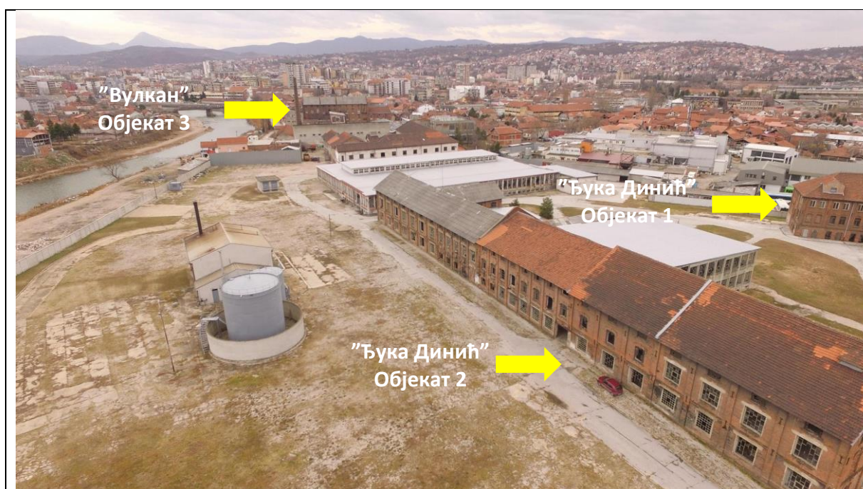
Fig. 19, Подручје ”Старог Вулкана” чине две архитектонско-функционалне целине; остаци некадашње фабрике гума ”Балкан”, односно ”Вулкан” (”Стари Вулкан”, Објекат 3) и фабрике коже ”Ђука Динић” (Објекат 1 и Објекат 2). Фото: ЗЗСК Ниш, стање на терену 2023.
