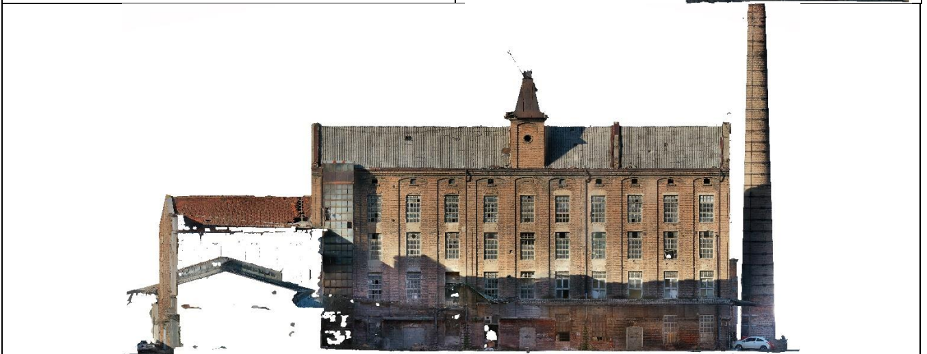
Fig. 20-22, Централна грађевина фабрике гума "Вулкан" (Објекат 3) са димњаком, поглед на североисточну фасаду из правца Нишаве, поглед на југозападну фасаду из Гумарске улице, и југоисточна фасада, поглед из атријума; стање на терену уснимљено у новембру 2023., Фото: ЗЗСК Ниш, 2023.
